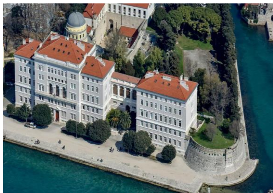
1. slika: zgrada Sveučilišta u Zadru
